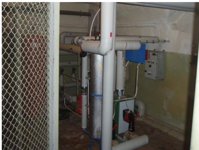
Joonis 4.11 Soojussõlm
