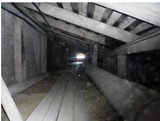
Joonis 4.9 Küttetorustik pööningul
