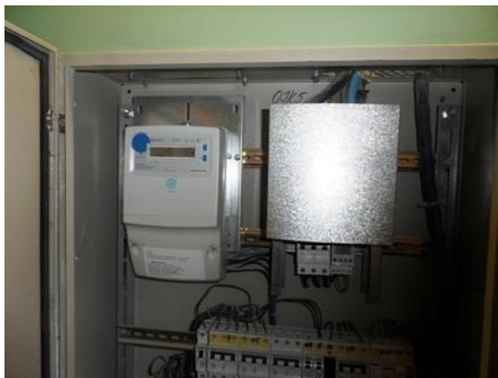
Joonis 4.30 Söökla elektriarvesti
