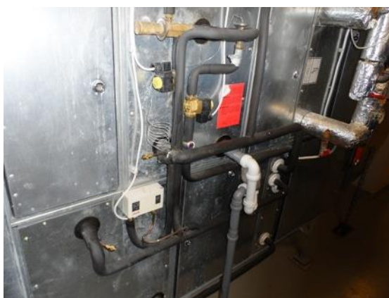
Joonis 4.23 Ventilatsiooniagregaati integreeritud otseaurustusega jahutusseade
