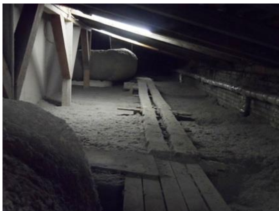
Joonis 4.20 Küttetorustik pööningul
