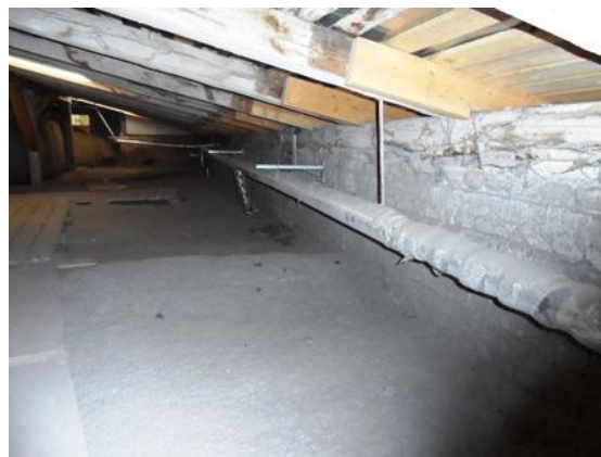
Joonis 4.20 Küttetorustik pööningul
