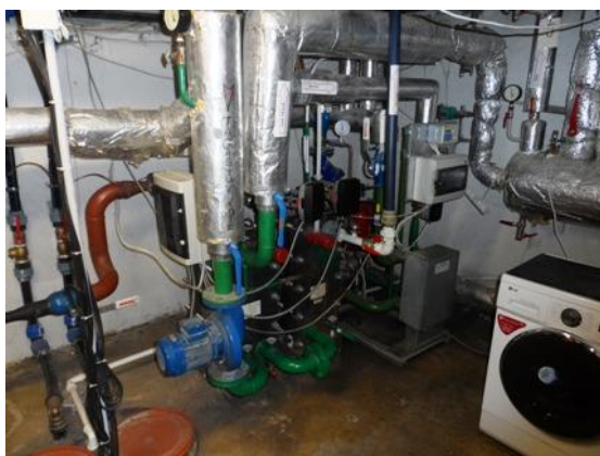
Joonis 4.22 Soojussõlm
