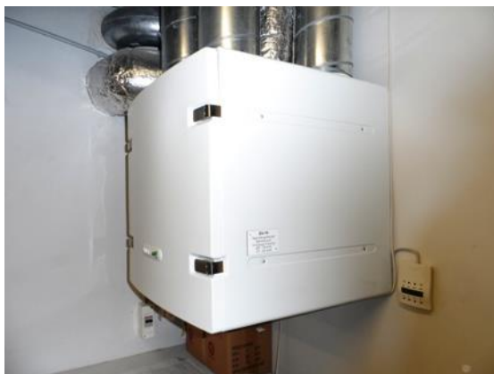
Joonis 4.17 Vallox ventilatsiooniagregaat
